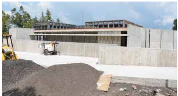
Construcción de los juzgados anexos
