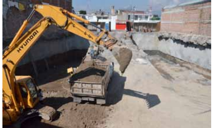
Avances en la construcción del Centro de Mediación de Morelia
